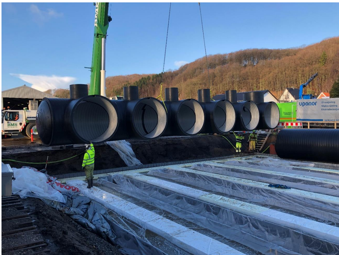
Rørbassin ved Vestbanevej
