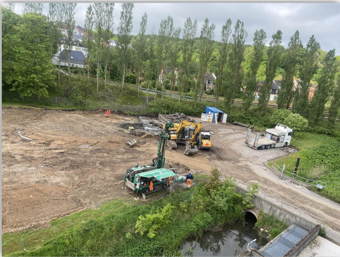
Indledende arbejder – nyt stort bassin på Vejle Renseanlæg
