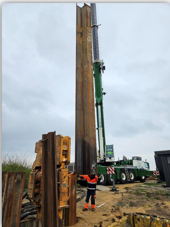
Nedsættelse af pumpestation ved Mørkholt Camping
