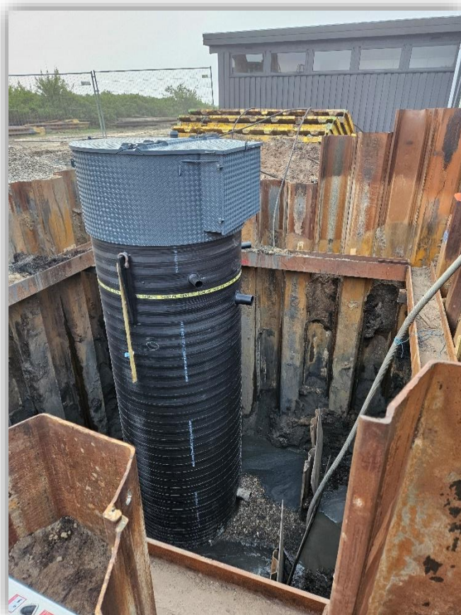
Nedsættelse af pumpestation ved Mørkholt Camping
