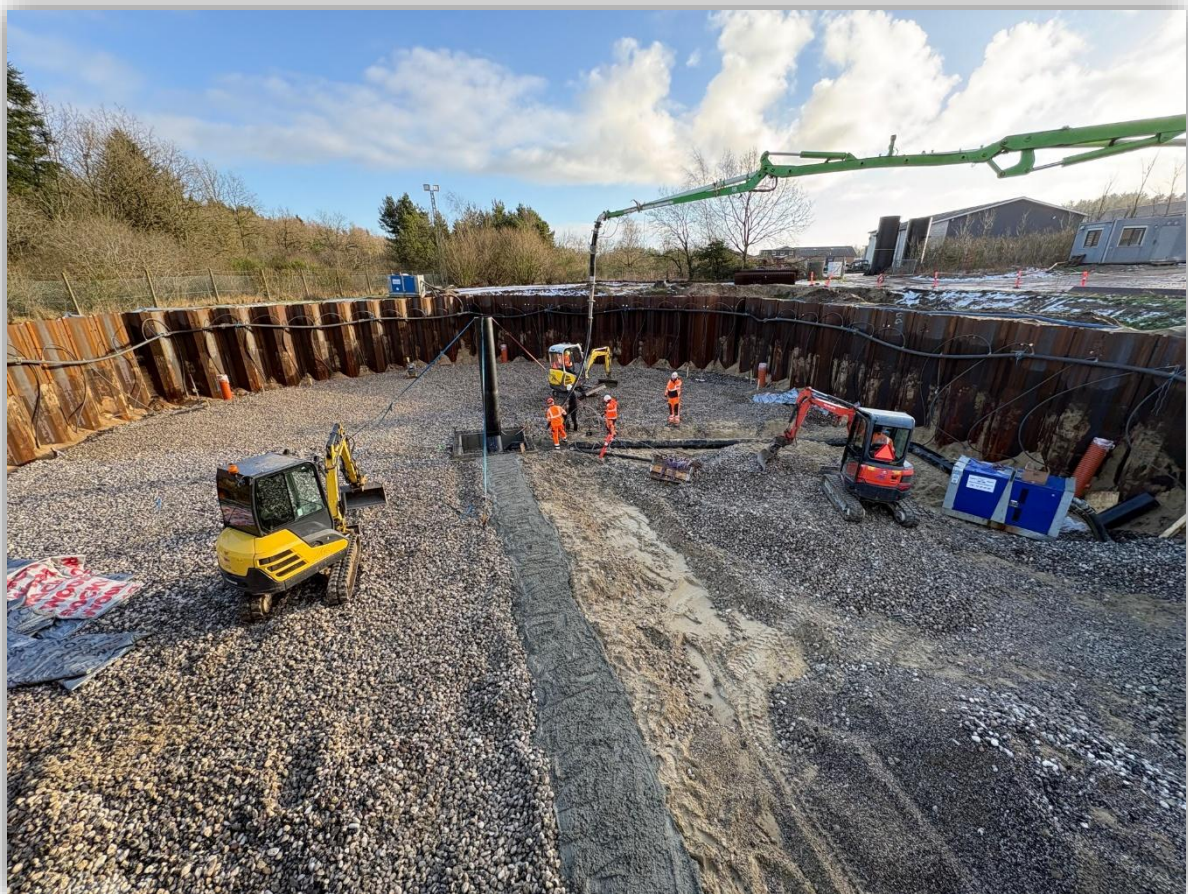
Ny efterklaringstank ved Givø Rensningsanlæg
