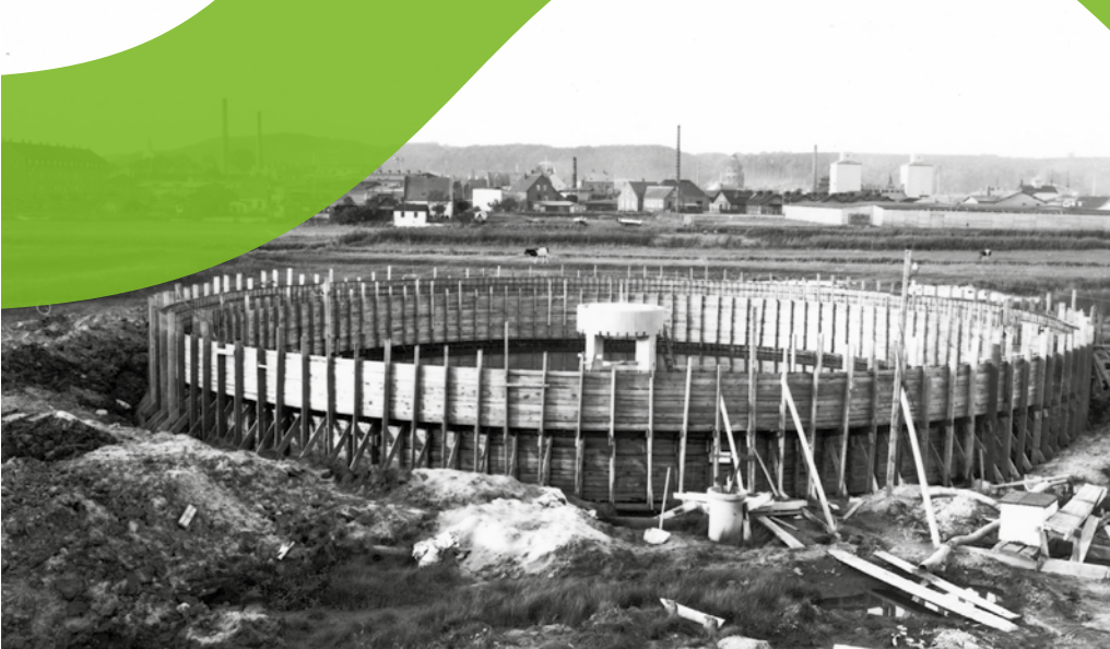
Fotograf: Johs. Rønvig Foto: Vejle Stadsarkiv Opførsel af forklaringstank, Vejle Renseanlæg 1943-44
