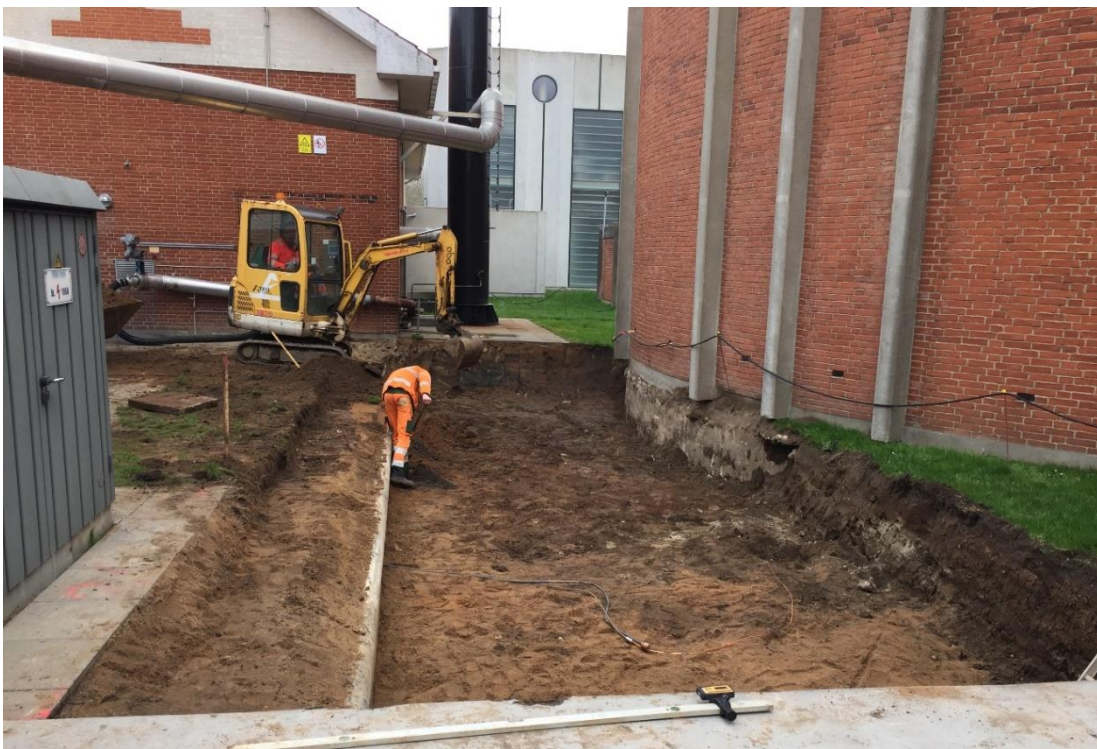
Klargøring af fundament til ny gasmotor
