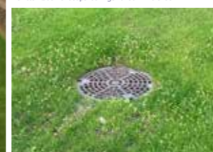
Rist i terræn i bunden af klimarenden. Vandet kommer op af risten, når a 1000 ledningens kapacitet er brugt.
