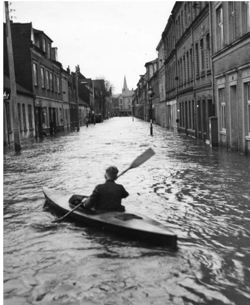
I 1941 blev byen ekstremt oversvømmet ved en meget kraftig vandføring i Grejs Å, som skyldtes tøbrud. I Staldgaardsgade (billedet) var det nemmere at padle frem end at gå.
