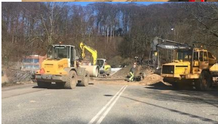
Nedgravning af rør under Østerbrogade
